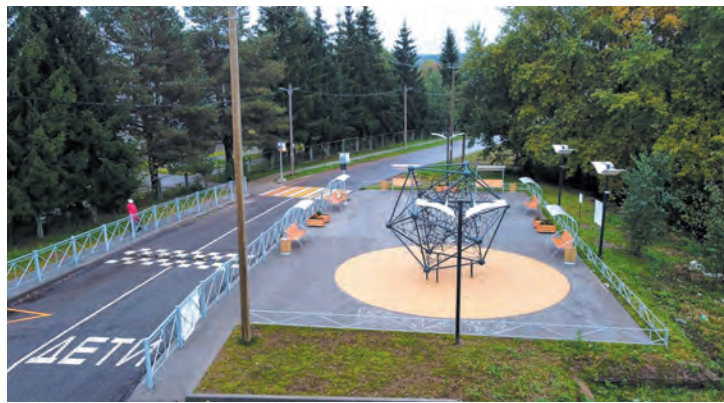
В 2024 году будут благоустроены общественные территории в 6 поселениях района
