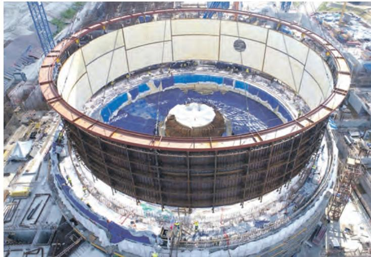
работать и впредь в таком же хорошем темпе, с безусловным соблюдением высокого уровня строительства и монтажа. Попутно с внутренней защитной оболочкой будем создавать и вторую — наружную. Она предохранит реактор и относящееся к нему оборудование от внешних воздействий — природных и техногенных. Эти работы стартуют уже в этом году.
